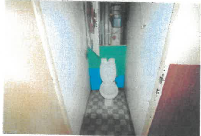
WC s inštaláčnou šachtou
