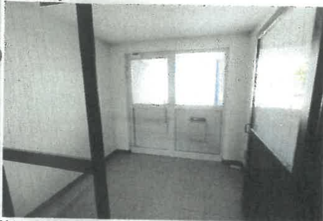
Vstupné priestory domu
