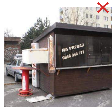
nevhodné umiestnenie technického zariadenia predajného stánku, nebezpečne zasahuje do priestoru Bratislava, Seberíniho ulica
