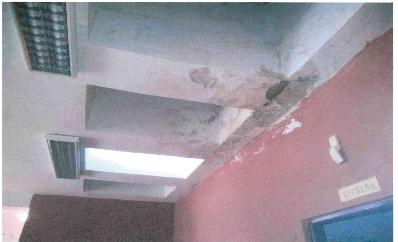
Objekt Vážská 34 Bratislava - rok 2021
