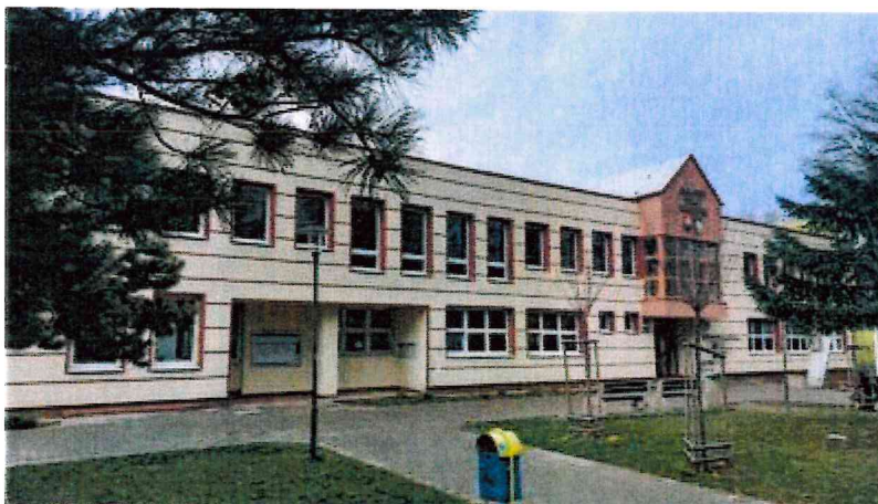
Zrekonštruovaný Miestny úrad mestskej časti Bratislava-Vrakuňa na Šíravskej ulici
