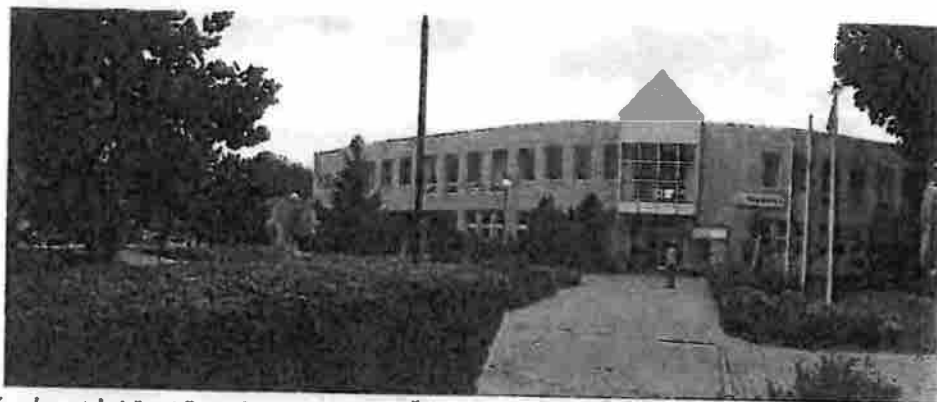
Miestny úrad mestskej časti Bratislava-Vrakuňa na Šíravskej ulici, ktorého rekonštrukcia je naplánovaná na rok 2021
